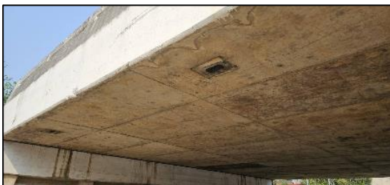
รูปที่ 34 ระบบระบายน้ำของถนนบริเวณห้วยแม่อาบ
